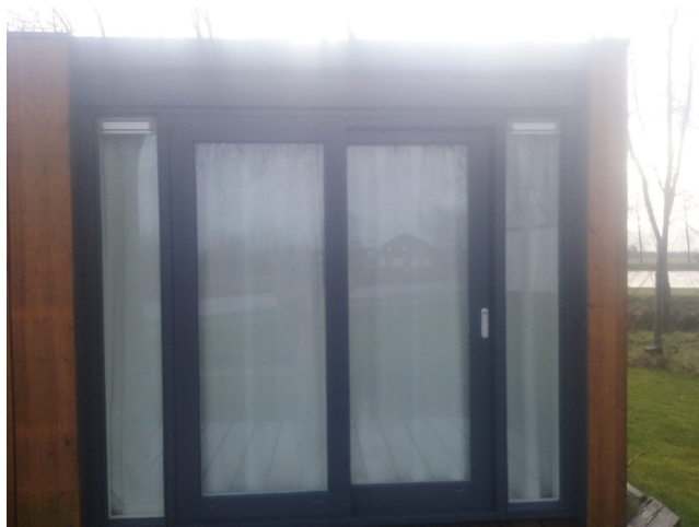
Ventilatie glasroosters naast het schuifgedeelte. Ventilatioerooster in draairaam.
