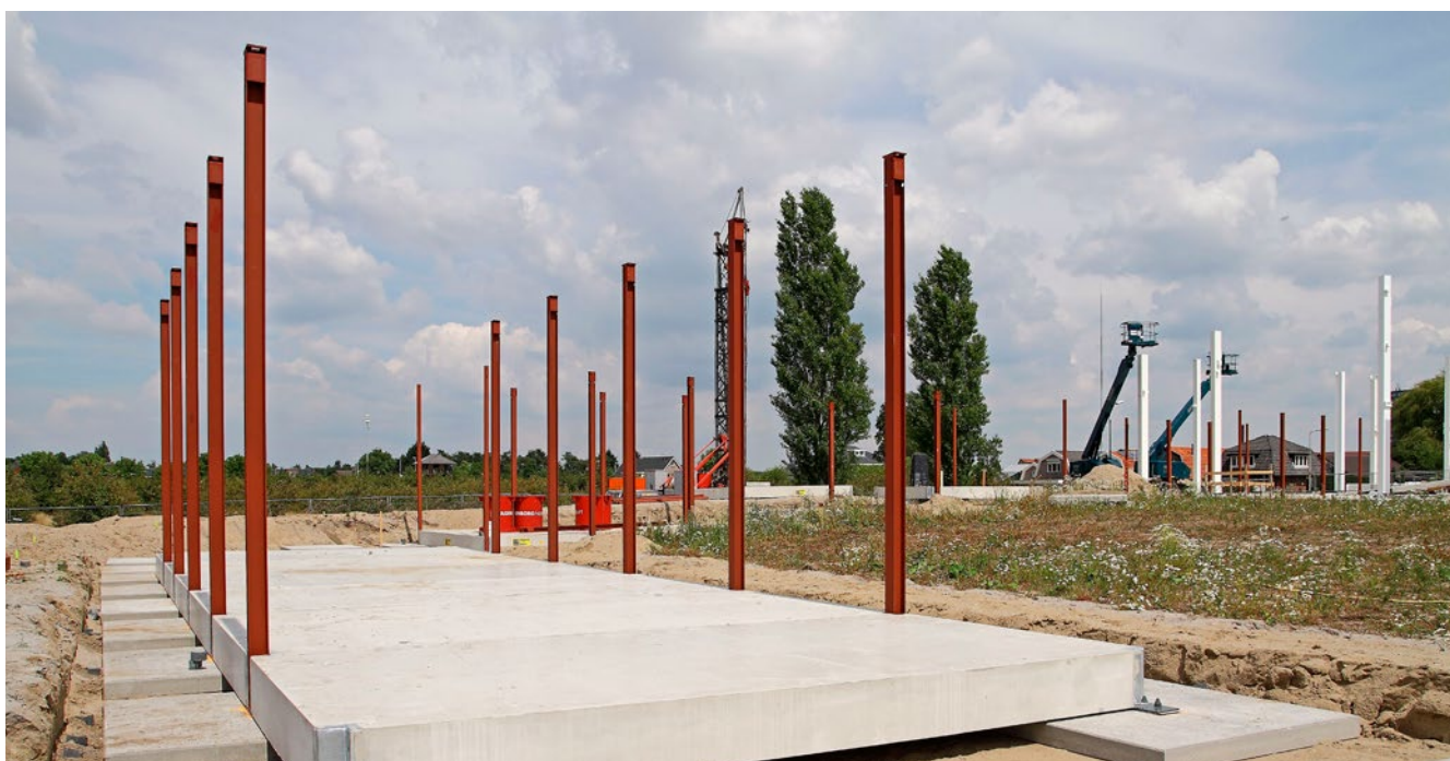
De eerste fase van de bouw is in volle gang. Op het zandbed van ongeveer 1 meter dik dat op het rijksmonument is aangebracht worden betonnen platen gelegd. Hierop rusten de vloerplaten van het gebouw. De eerste staanders van de opstand van het gebouw zijn reeds geplaatst.
