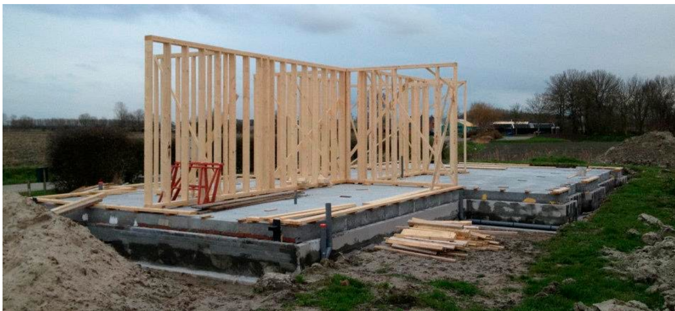
De eerste fase van de bouw is voltooid. De strokenfundering is gelegd evenals de vloer van het huis. De eerste delen van het houtskelet zijn opgesteld. Aan deze zij steekt de fundering en de vloer aanzienlijk boven het maaiveld uit. Hier moest het maaiveld worden aangeraseerd om aan te sluiten bij het vloerniveau van het huis.
