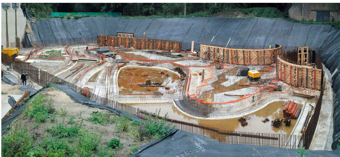
De bouw van het museum in een vroeg stadium. De banen in de grond geven het beloop van de strokenfundering aan. De bekisting van de eerste gebogen wanden staan al overeind.
