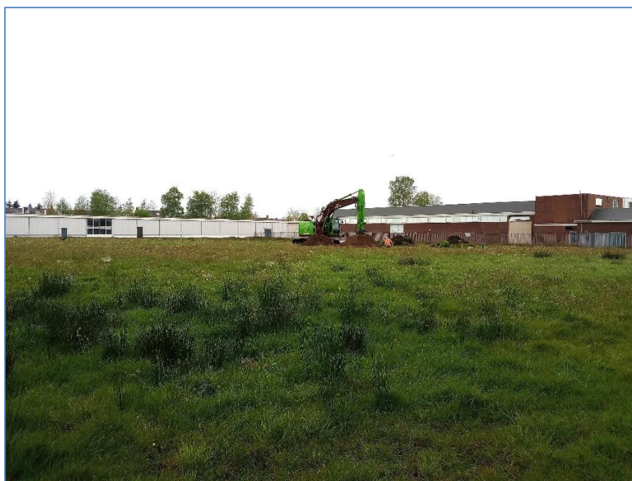
Figuur 7. Overzichtsfoto onderzoeksgebied, start van het onderzoek (aanleg WP1). De fotorichting is noord.
